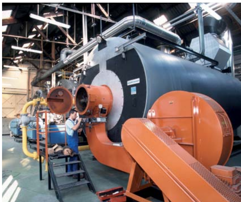
Maintenance par technicien d'une chaudière industrielle « BAS NO x » dans une usine textile à Amiens. Sa conception est destinée à minorer les émissions d'oxyde d'azote dans le processus de combustion. Réduction à la source des émissions polluantes des sources fixes.
