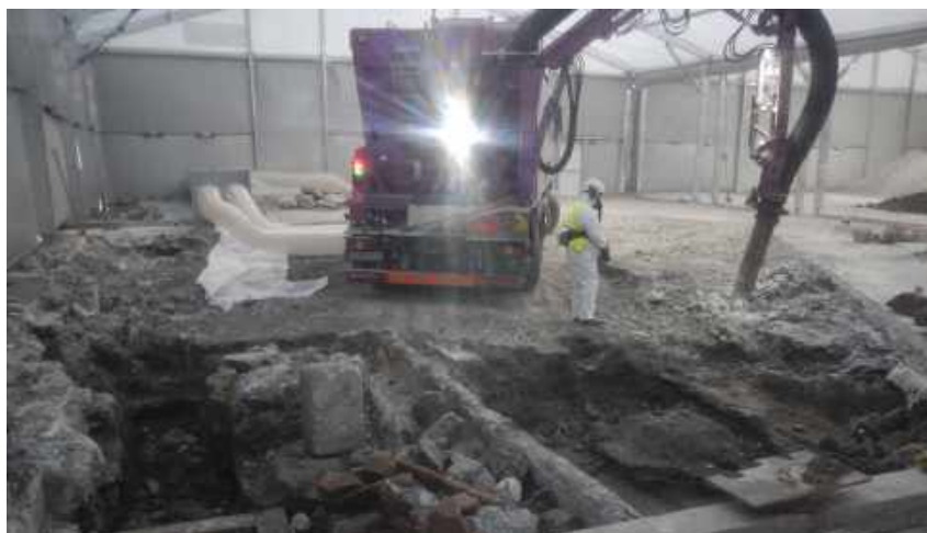
Un chantier complexe de réhabilitation industrielle réalisé par Ortec Soleo portant sur la gestion de matériaux mercuriels. Des conditions de réalisation très contraintes d'un point de vue techniques et HSSE avec ici tente de confinement ventilée et terrassement à l'aspiratrice.
