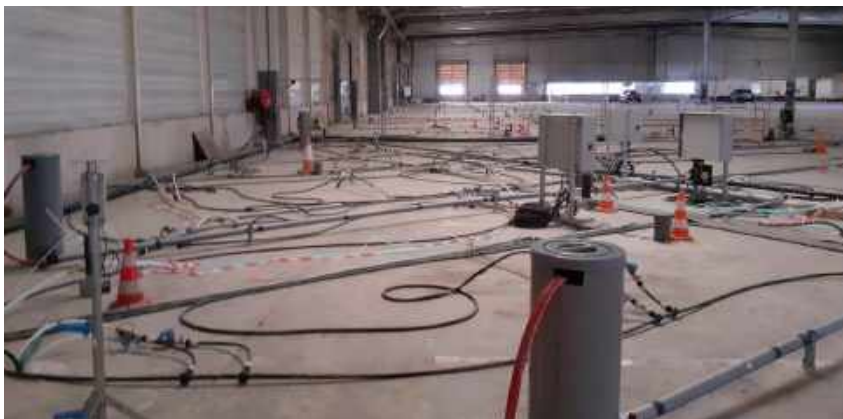
Un chantier de dépollution par désorption thermique sous bâtiment mené par Colas. La société, qui utilise toutes les techniques disponibles, a développé un outil numérique permettant d'évaluer a priori le bilan carbone des travaux.
