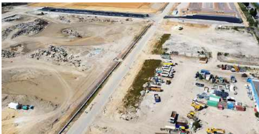
La revitalisation de l'ancienne raffinerie Petroplus à Petit-Couronne (76) s'est appuyée sur le service d'audit et de recommandations ValgoScan.
